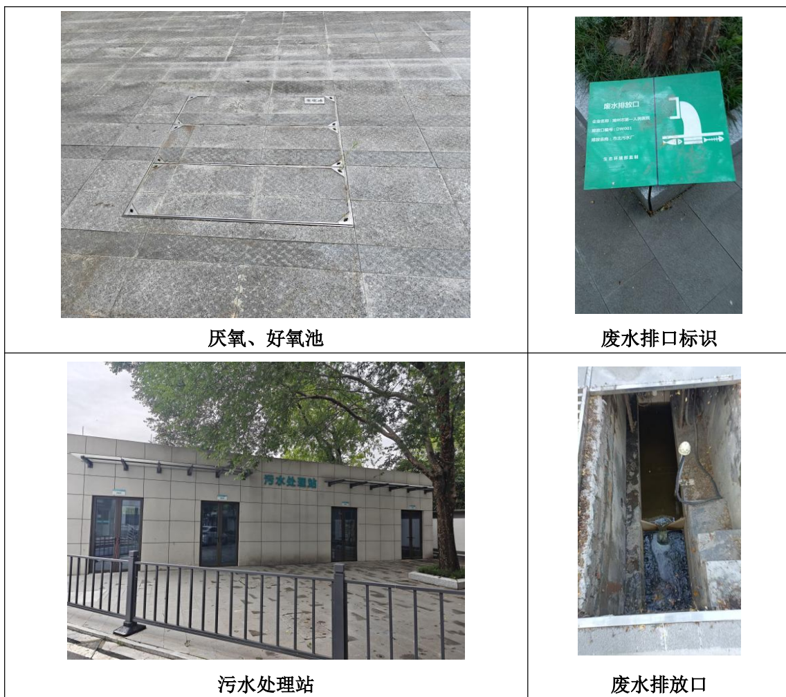
图 4.1-1 废水处理设施照片
